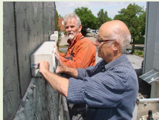
Ganz oben: Montage von Mauerseglerkästen.
